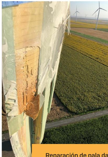
Reparación de pala dañada por impacto de rayo mediante plataforma suspendida.
