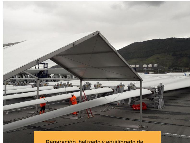
Reparación, balizado y equilibrado de palas en campa de acopio.
