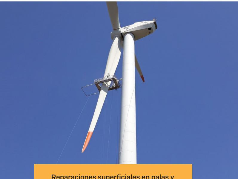
Reparaciones superficiales en palas y tramos mediante plataforma suspendida.
