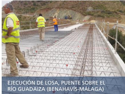
EJECUCIÓN DE LOSA, PUENTE SOBRE EL RÍO GUADAIZA (BENAHAVÍS-MÁLAGA)
